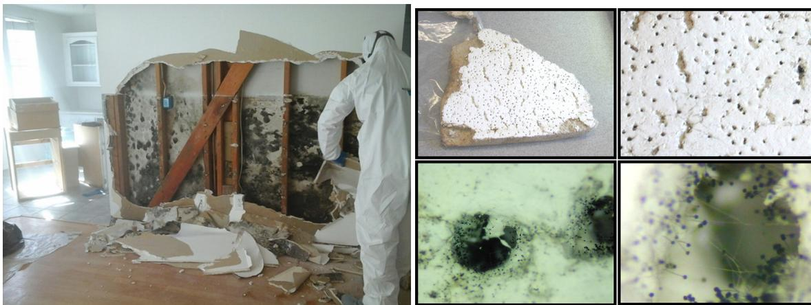
(Gauche) Moisissures derrière une cloison - (Droite) Moisissures dans des plaques de faux-plafond
